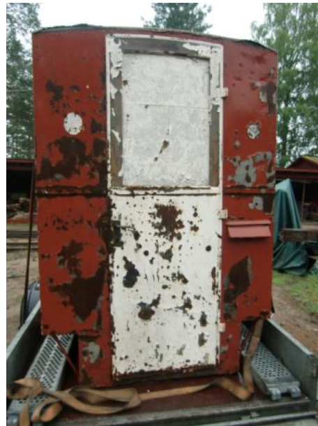
Gaveln. Dörren OK bortsett från behov av glas och färg Höjd från underkanten till takets över- kan är 191 cm
